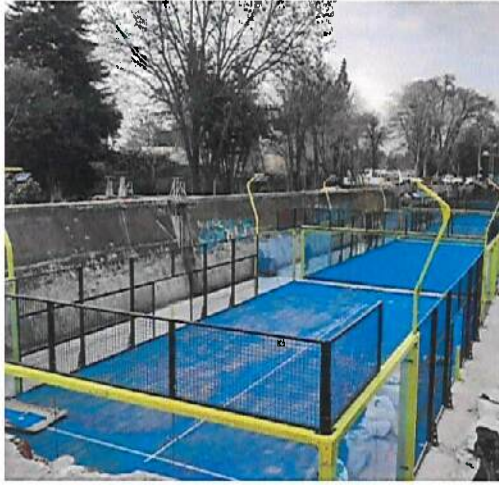
Canchas de Pádel en ejecución
