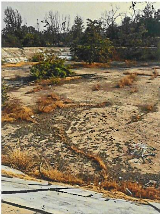
Estanque circular. Estado en que fue recibido por la Municipalidad
