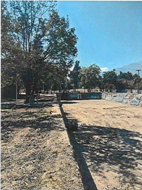
Estanque rectangular. Posterior a los trabajos de limpieza.
