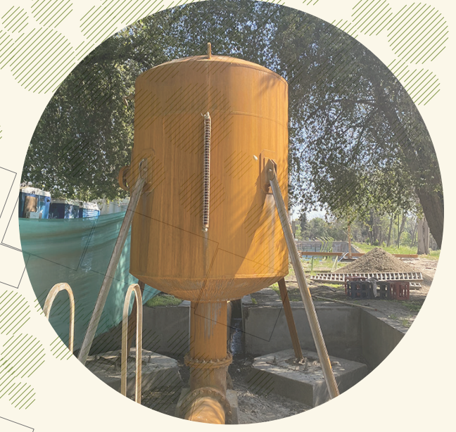
Puesta en valor de la Infraestructura del agua
