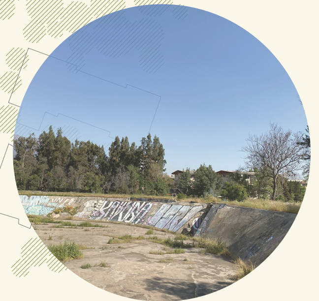
Estanque circular a recuperar (medida: Ø 65 mts)
