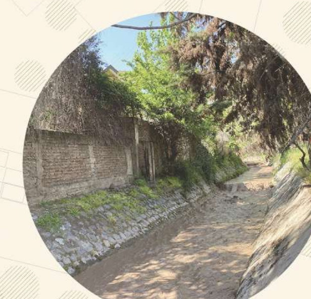
Puesta en valor Canal de Ramón Capacidad de porteo 20m³/s
