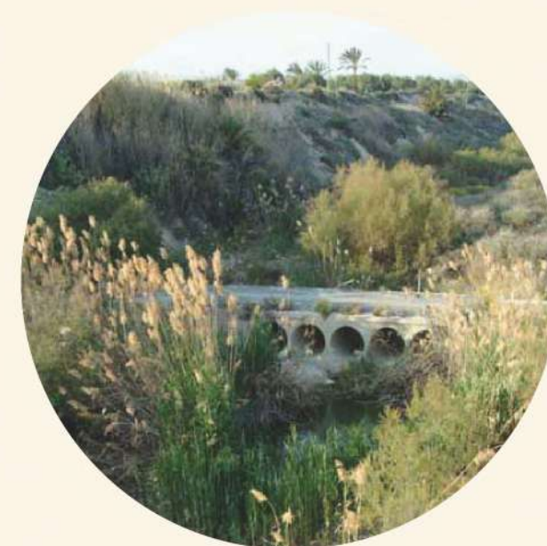
Manejo de las Aguas en la Quebrada Infraestructura hidráulica en el Rio Chicamo, Murcia
