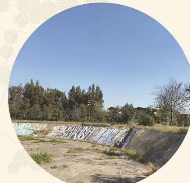
Estanque circular a recuperar (medida: Ø 65 mts)
